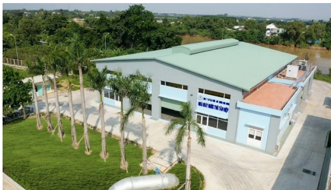
Nhà máy nước thô Tân Hiệp công suất 600.000 công
